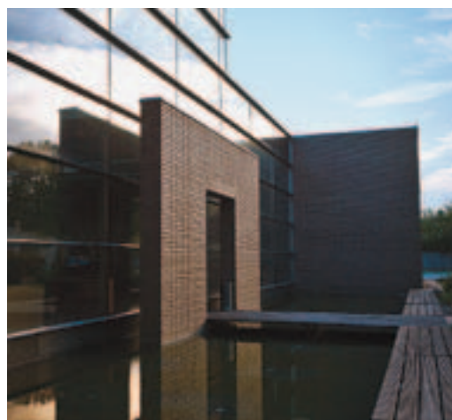
Dunaújvárosi Főiskola "A" épület
